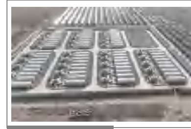
Tumushuke PV-ESS Project Scale: 350MWh
