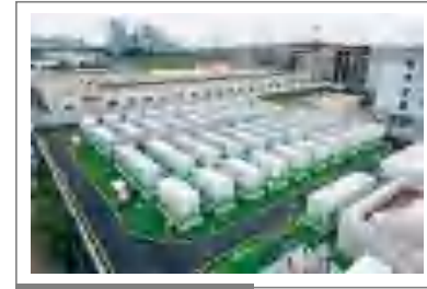
Guangxi Nanning ESS Project Scale: 100MWh
