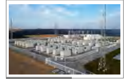
Shizuishan PV-ESS Project Scale: 200MWh
