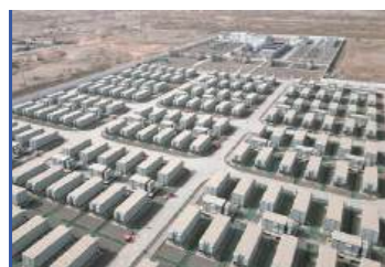
新疆伽师县 600MWh 光伏发电项目
