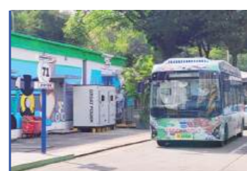
深圳巴士公交 60MWh 充电站项目
