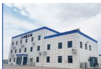
内蒙古乌兰察布 180MWh 示范项目
