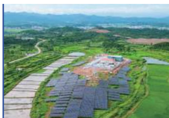
江西吉安 15MWh 渔光互补储能项目
