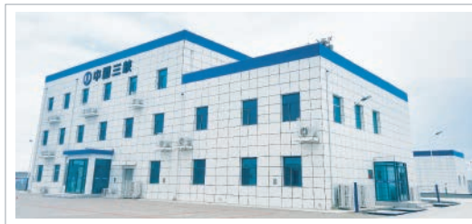
乌兰察布 180MWh 绿色电站示范项目
