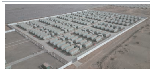
伽师县 600MWh 光储项目
