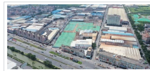
佛山市顺德区科力有色金属有限公司 5.2MWh 项目
