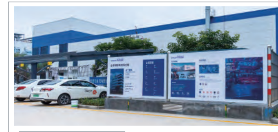
广东珠海光储充一体化超充站
