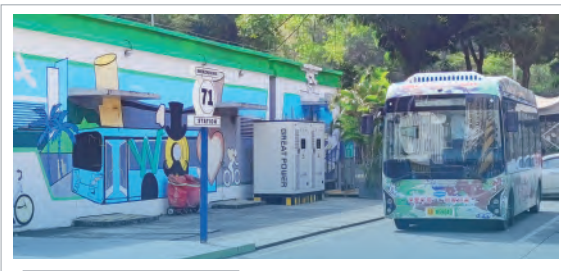
深圳巴士公交 60MWh 充电站项目
