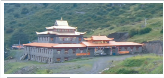
四川康定 392kWh 光储离网储能项目
